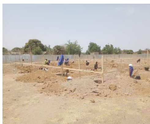
Travaux de fouille du marché rural de Kélo
