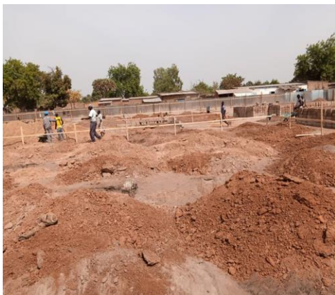
Travaux de fouille du marché rural de Béré
