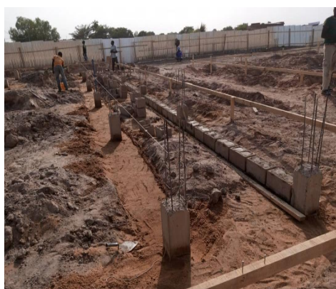
Travaux de fondation du marché rural de Lai
