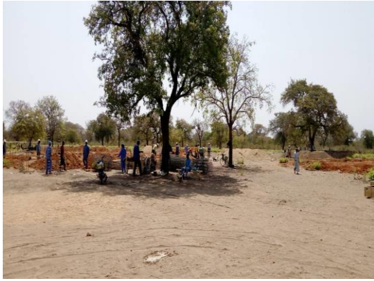
Travaux sur le marché rural de Dono-Manga
