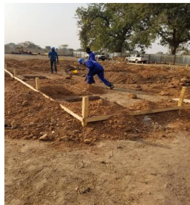
Travaux de fouille du marché rural de Dafra
